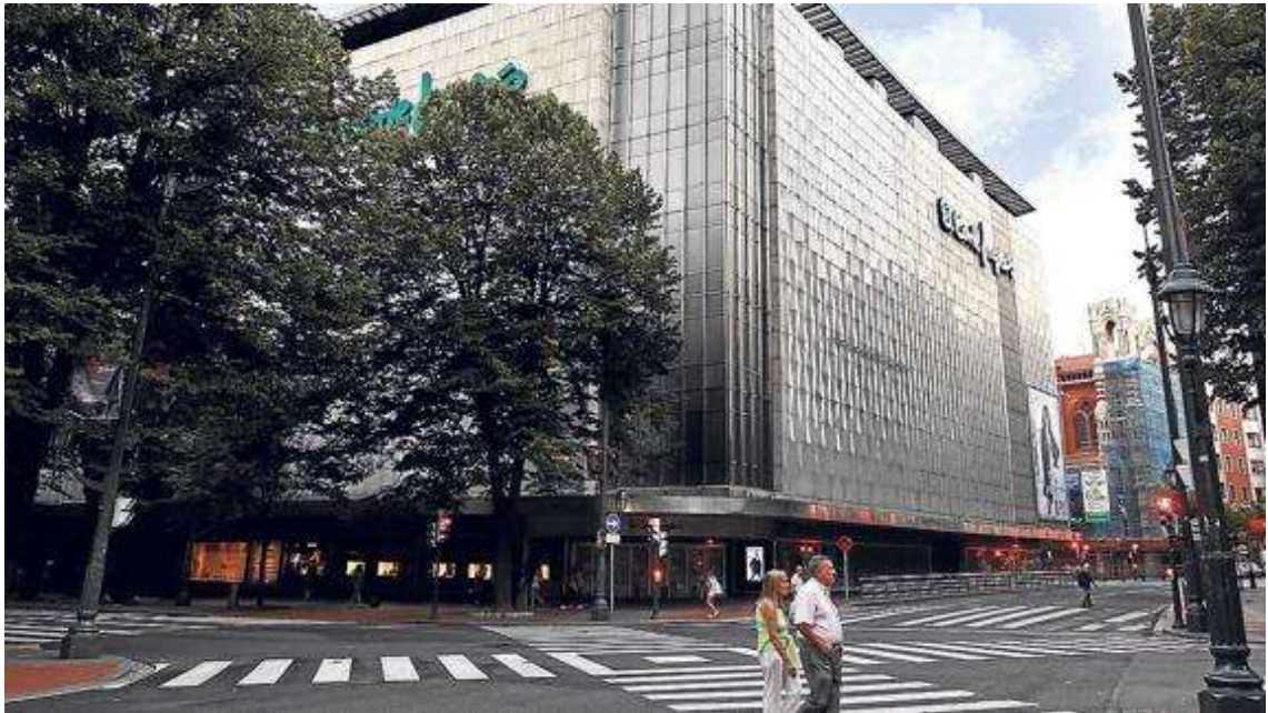
Corte Inglés de la Gran Vía de Bilbao
