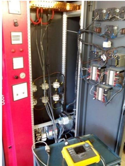
*Figura 7.2.5. - Cuadro eléctrico con Fluke 1735 conectado a barras*
