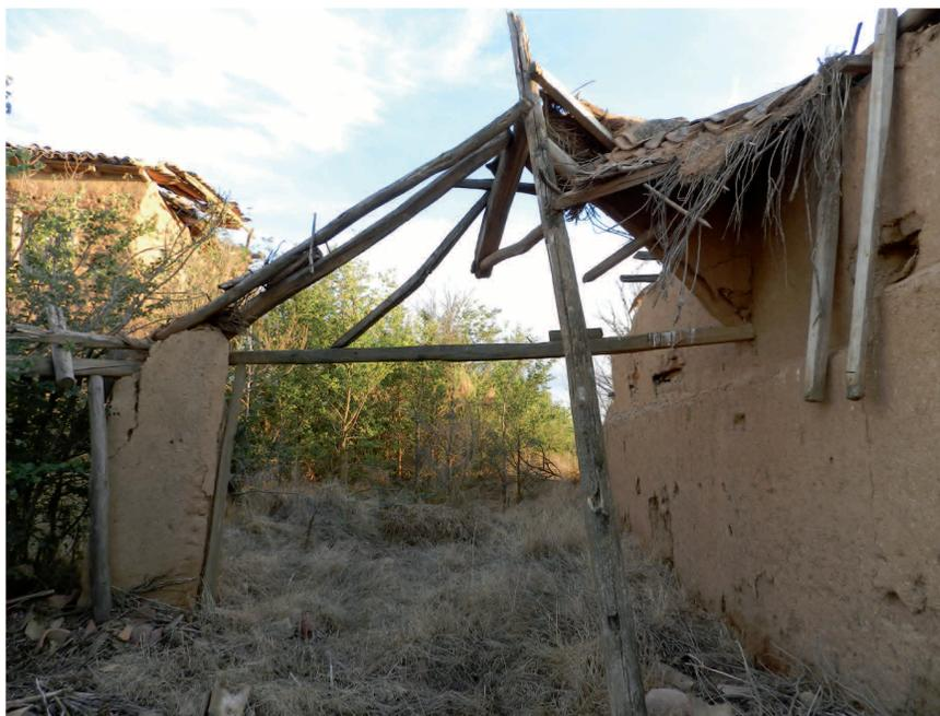
Figura 3. Estructura en adobe en proceso de derrumbe en Villapeceñil (Villamol, León)
