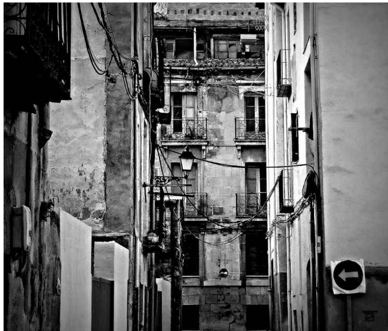
Derribo Casa de los Jesuitas en C/Rodríguez Paterna 5
