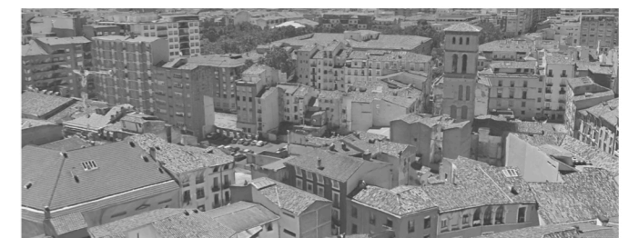
Cubiertas del entorno.
