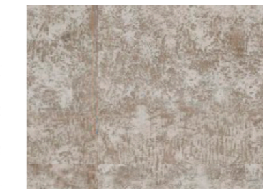
Enrasado en fachada.
