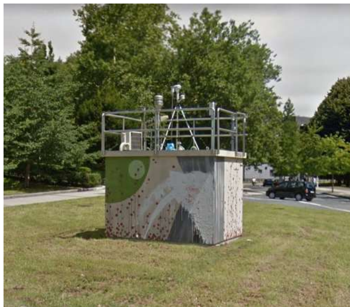
Figura 11: Estación medioambiental de la Av. Tolosa
