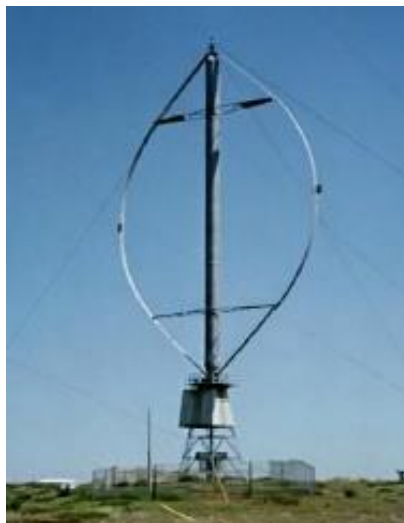
16. irudia. Darrieus motako aerosorgailua
