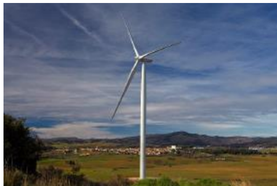
1. irudia. Ardatz horizontaleko hiru paladun aerosorgailua.
