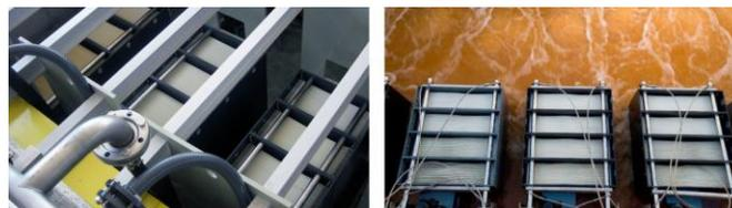
Figura 23: Izq: Detalle del conjunto placa-membrana. Dcha: Funcionamiento del módulo. [45]
