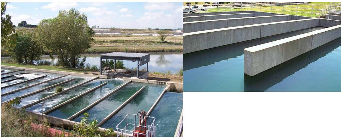
Figura 14: Izq: Perspectiva de cámara de cloración. Dcha: Detalle del tanque de cloración. [28]
