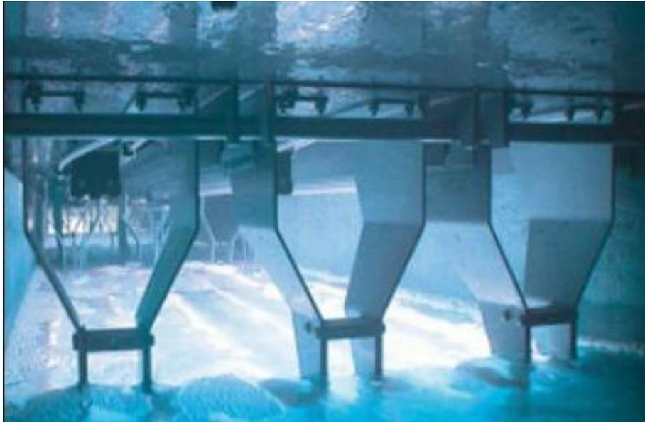
Figura 17: Agitación en tratamiento de afino de agua depurada con ácido peracético. [36]
