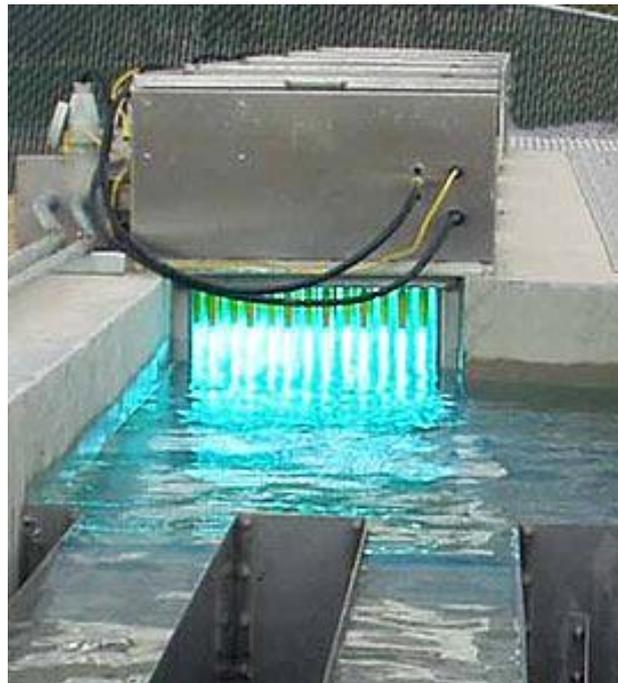
Figura 16: Tratamiento terciario de agua residual con radiación UV. [34]
