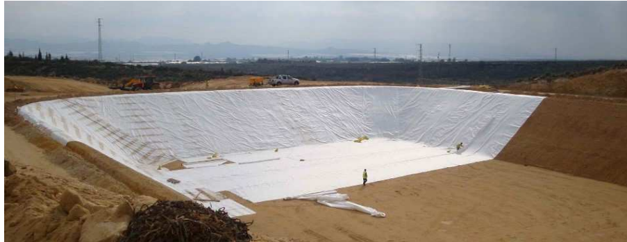
14.Irudia. Biltegiaren geotextila
