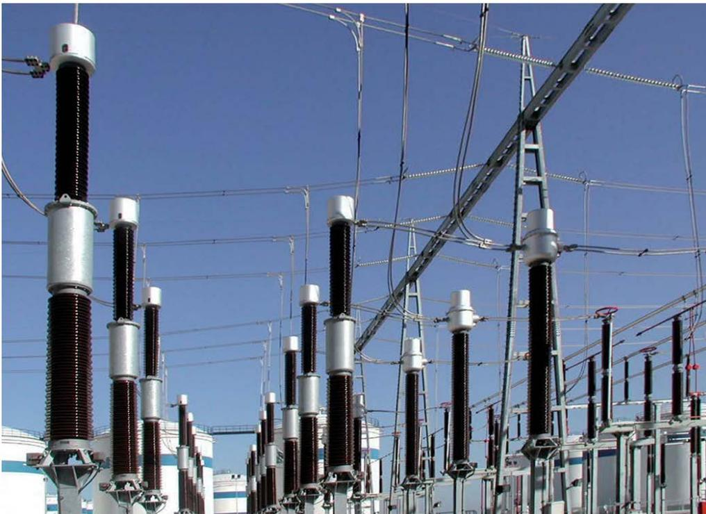
*Figura 3. Transformadores de tensión*
