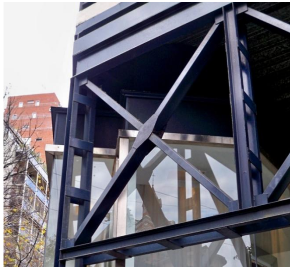
Figura 4. Ejemplo de arriostramiento en Cruz de San Andrés
