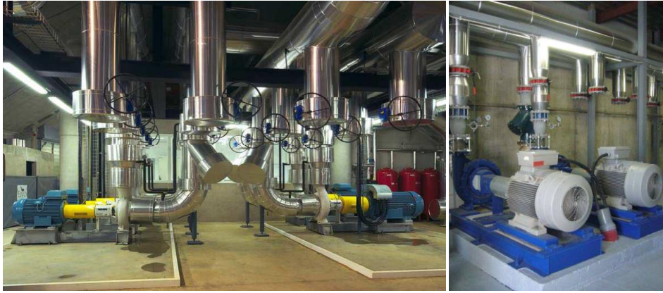
8.Irudia: DH sistema baten ponpaketa sistema [4.I].
