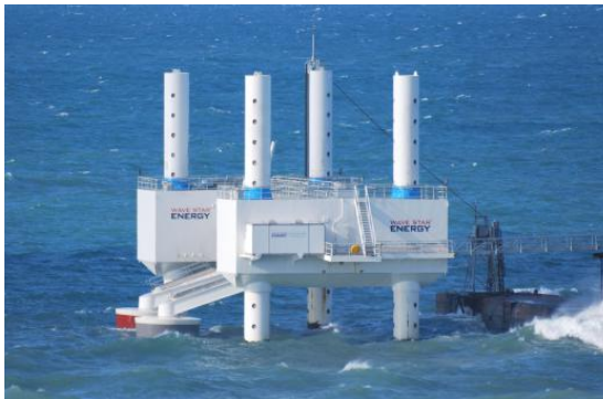
Figura 9-14: Wavestar a escala 1:2 instalado en 2009 en Hanstholm (Wavestar, 2018)
