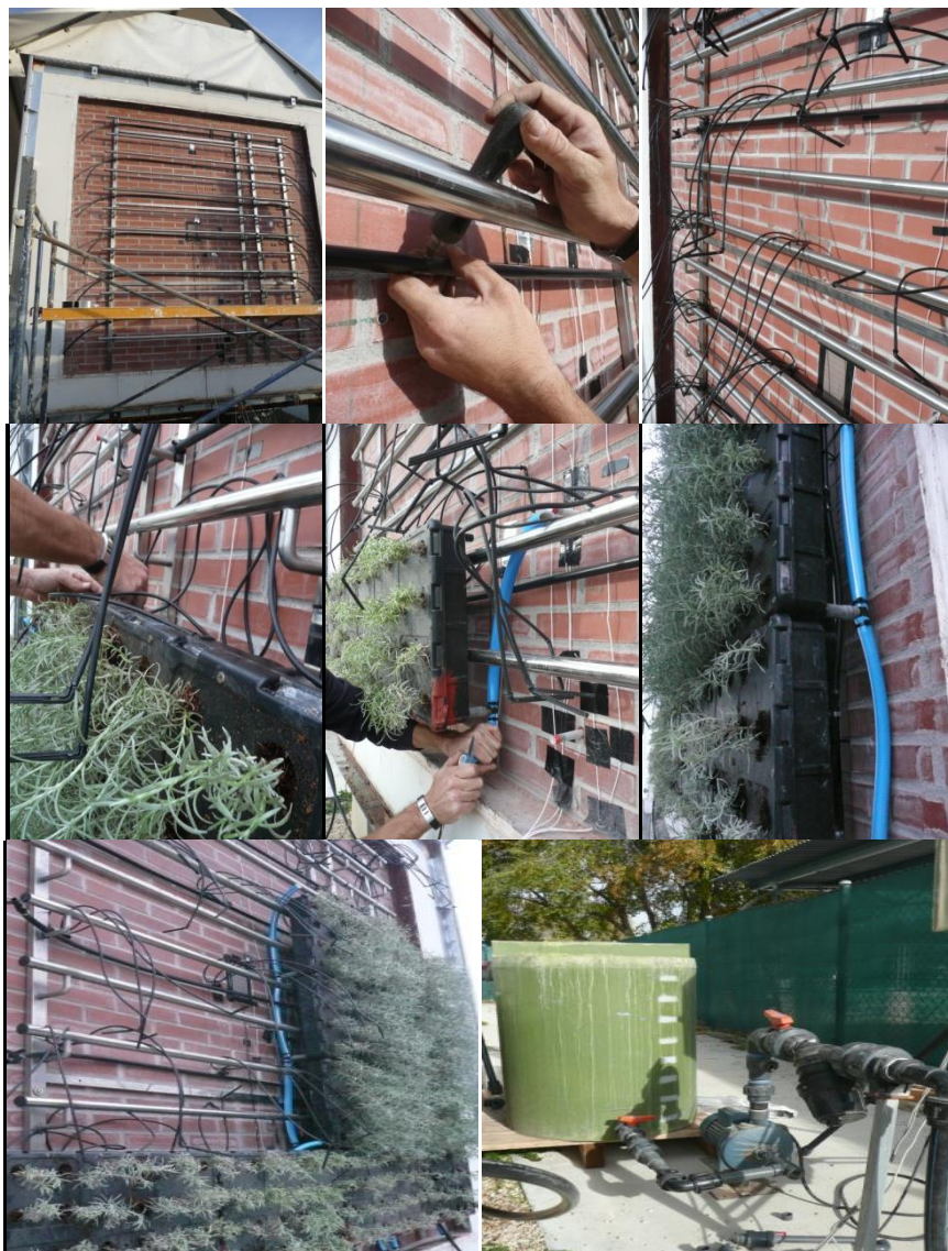
Fig. 2.13 Detalle del proceso de montaje del sistema de riego y drenaje. Arriba: Colación del sistema de riego, mangueras de riego, goteros autocompensantes y piquetas en los módulos. Abajo: instalación del sistema de drenaje y del sistema de bombeo
