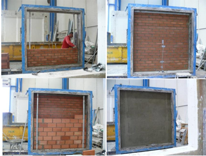
Fig. 2.6 Detalle del levante del ladrillo y raseado del muro base de doble hoja
