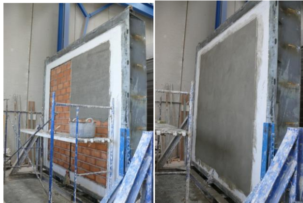
Fig.2.8 Fotografía de la aplicación de revestimiento de mortero de cemento sobre el muro base
