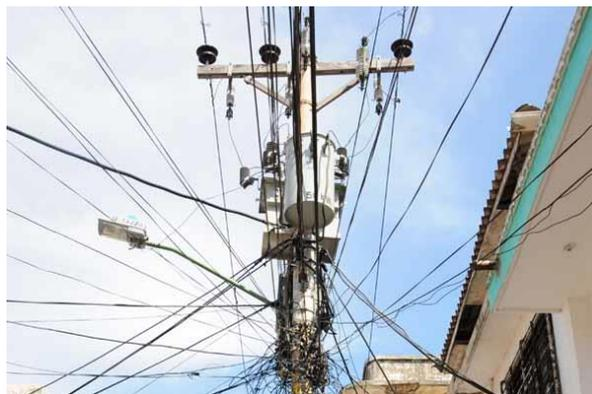
Figura 5.4: Maraña de cables con transformador en Barranquilla, Colombia [20].
