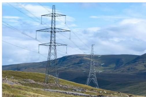
Figura 5.5: Línea aérea de doble circuito con armado hexagonal en Escocia [22].
