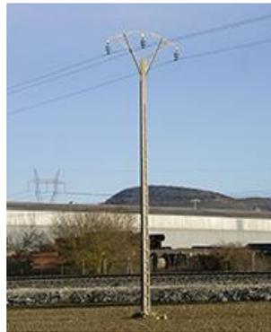
*Figura 5.11: Apoyo de hormigón en línea de distribución.*
