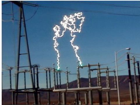
Figura 5.8: Arco eléctrico entre bornes de un seccionador.
