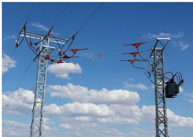
Figura 2.2: Línea aérea de media tensión con centro de transformación a baja tensión [9].
