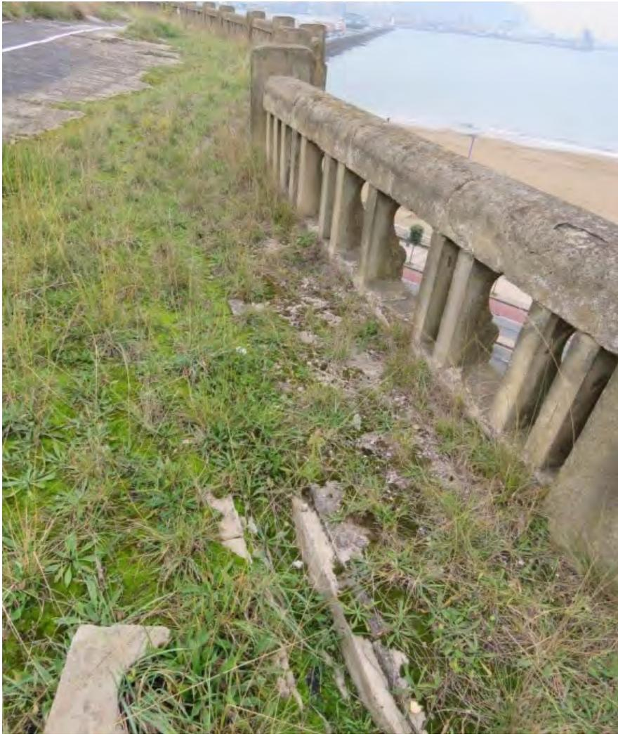
Figura 215 y 216. Acumulación de vegetación y canalización tupida en la terraza superior
