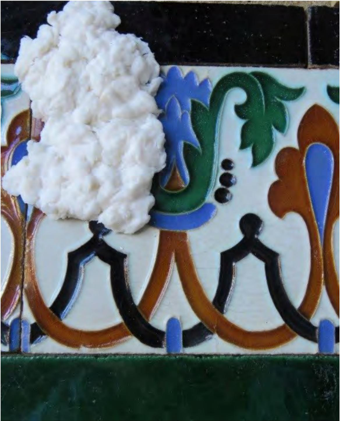
Figura 226 A y B. Papeta de celulosa impregnada con agua desionizada
