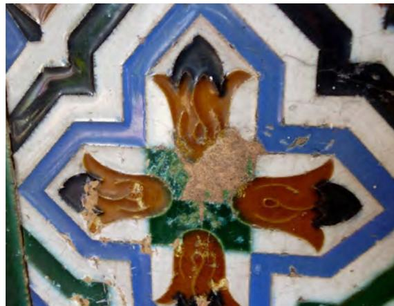
Figura 68 y 69. Detalle de roturas de azulejos provocadas por el punteado de los vidriados
