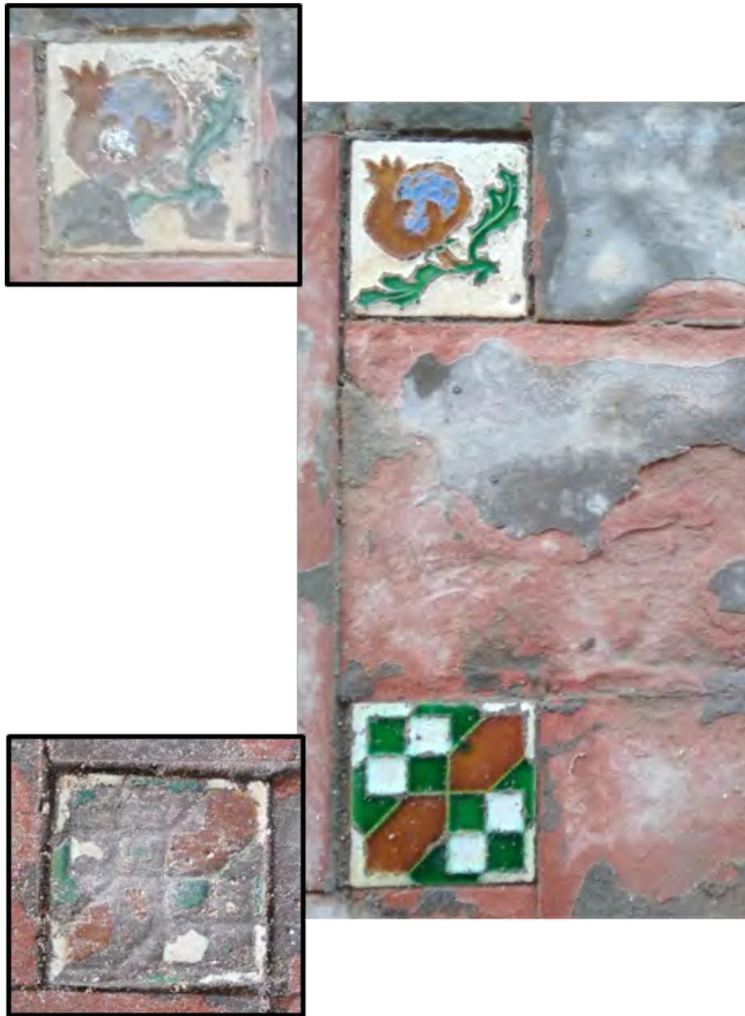
Figura 221 A, B, C, D y E . Antes y después de la limpieza de olambrillas en la galería SW
