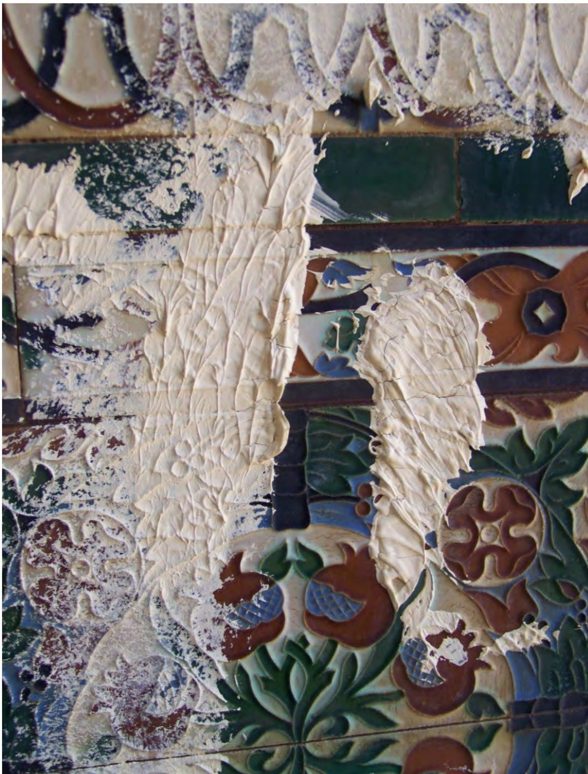
Hemos tomado una muestra de este material, tanto del empaste de la columna, como del grafiti del muro -donde aparecía este producto empastado- para hacer análisis químicos y determinar cuál era su composición. Mediante un espectrómetro Raman portátil innoRam B & WTEKINC (EE. UU.), que proporciona un láser de excitación de 785 nm, se han obtenido datos a tener en cuenta en la extracción del material a eliminar.
