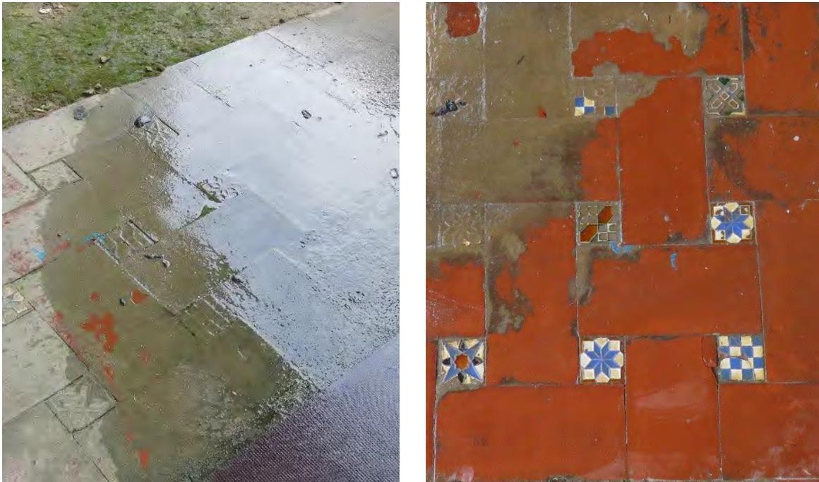
Figura 218 A, B. Antes y después de la limpieza de calcificaciones en suelo de la galería NW
