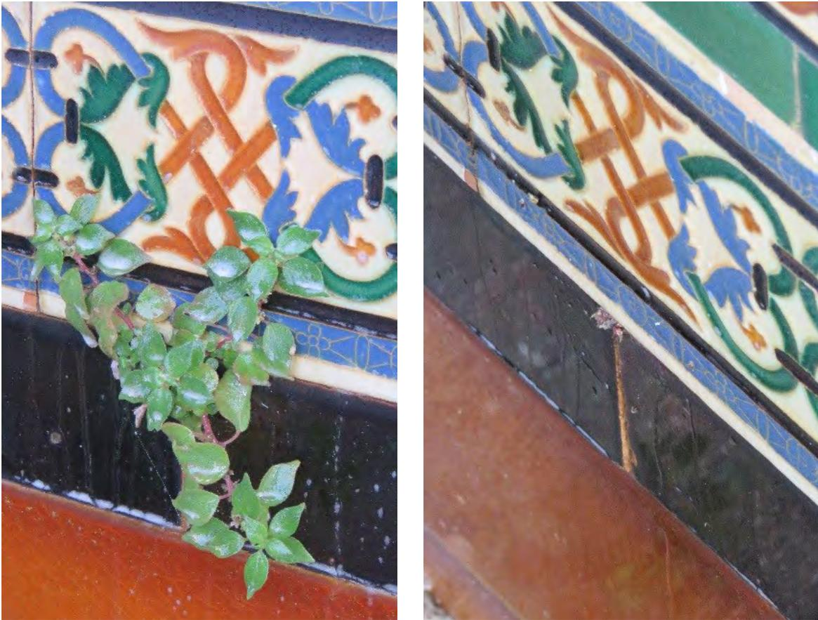
Figura 233 y 234. Antes y después de la aplicación de la metodología a realizar mediante jeringuilla
