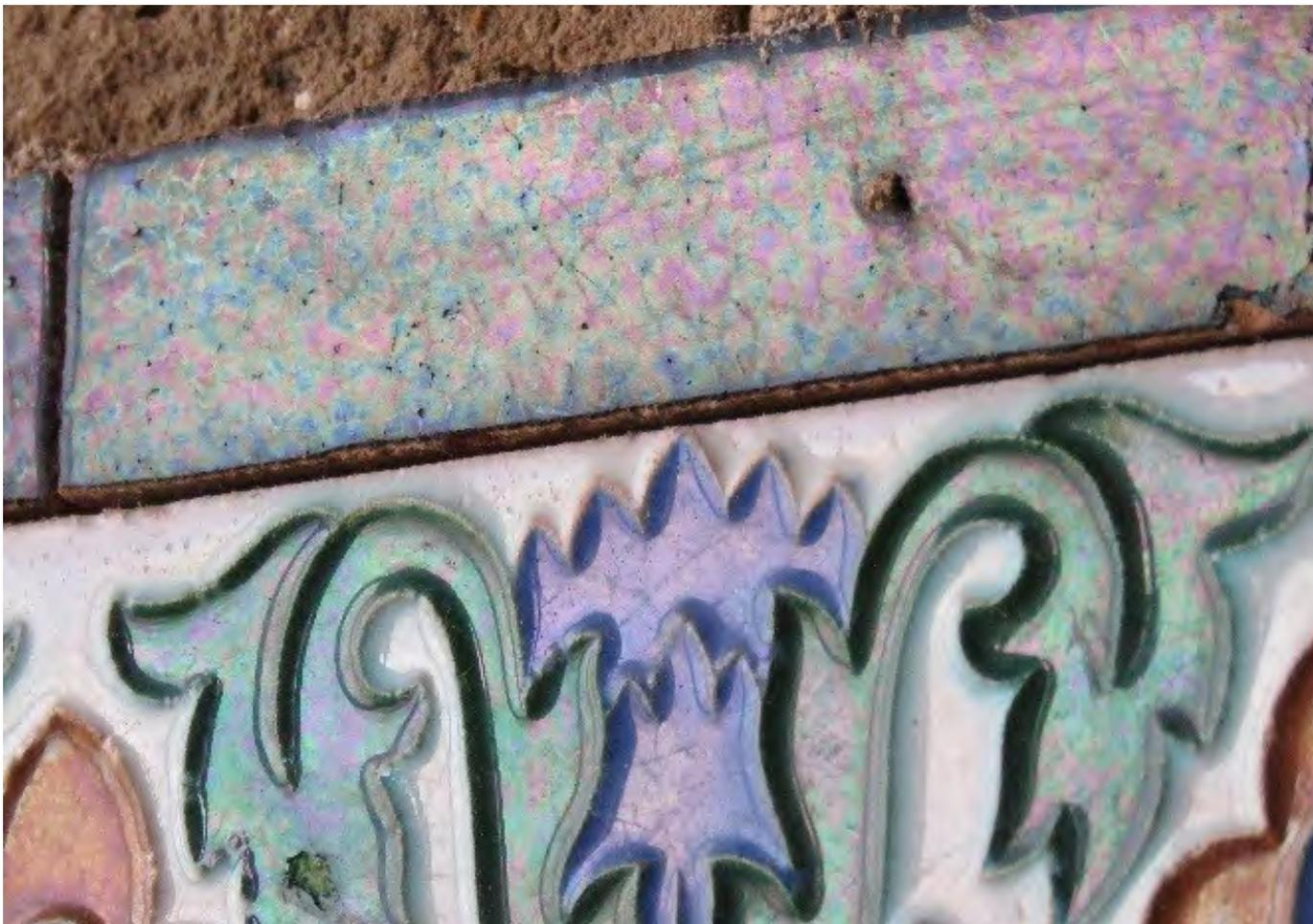
Figura 106. Detalles de los tornasolados producidos en la capa de vidriado
