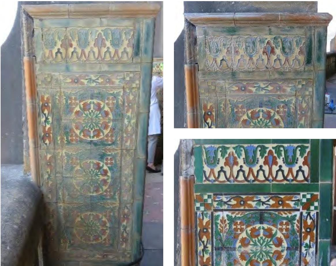
Figura 225 A, B y C. Proceso de limpiezas de pátinas blanquecinas
