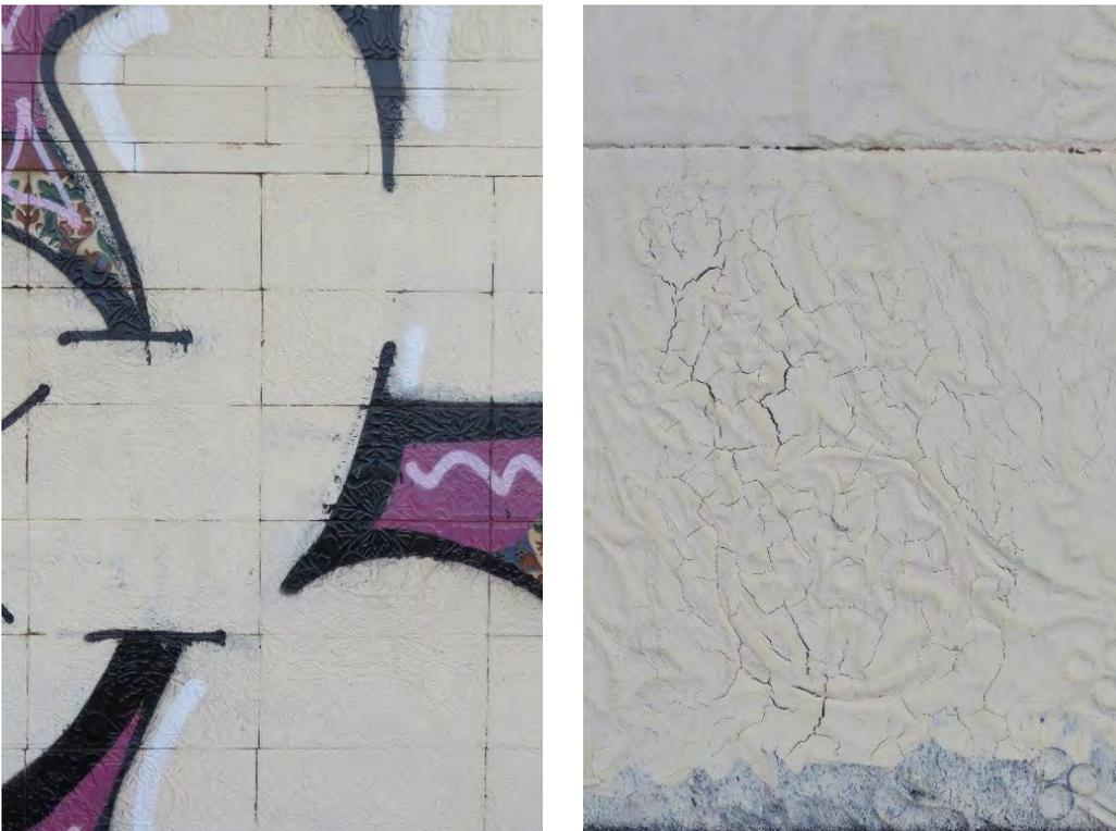
Figura 200 A y B. Grafiti y detalle de la pintura aplicada con rodillo
