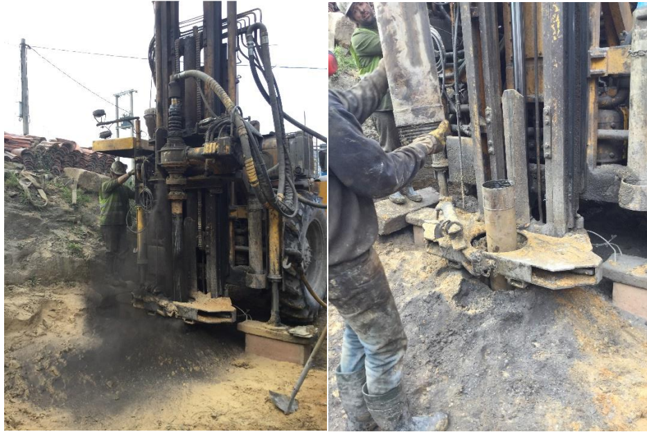
38. Irudia Ezkerrean zundaketa lehenengo metroetan, kolore iluneko ahutza materia organiko kantitateagatik, eskuman, kamisak ezarpena.
