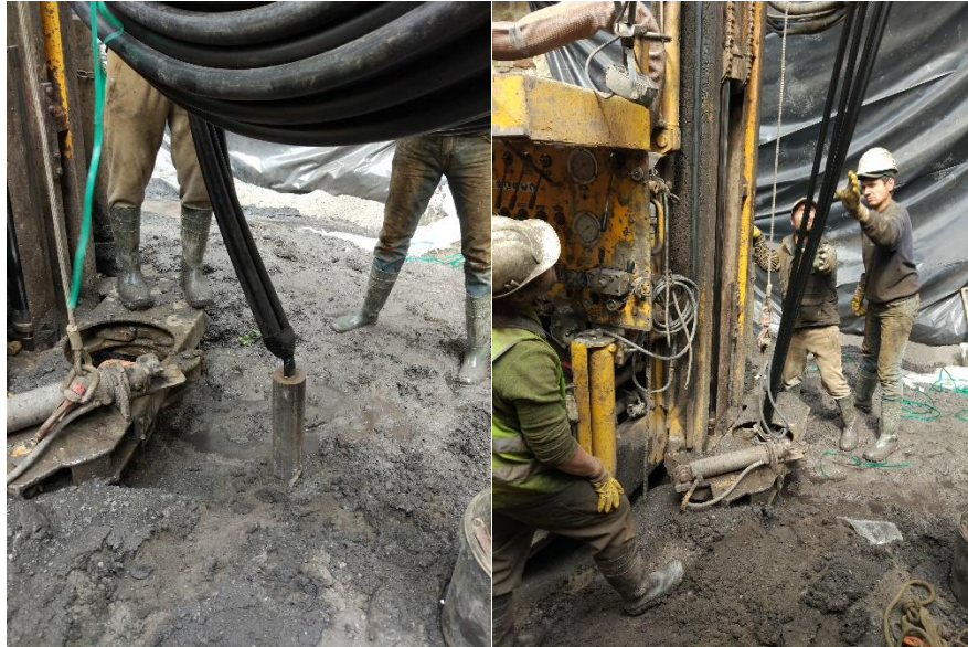
40. Irudia Ezkerrean zundan kokatzen den hila, eskuman zundaketan zunda sartzen.
