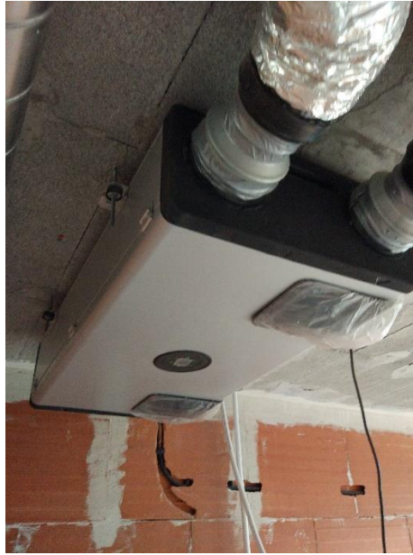
29. Irudia Aireztapenaren muntaia
