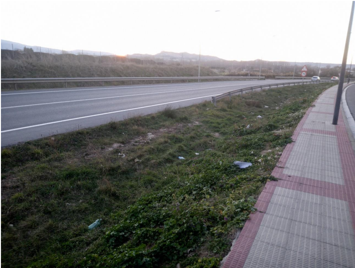
FIGURA 1.4: Visualización de la obra de contención existente en el lado de la calle Gustavo Adolfo Bécquer.
