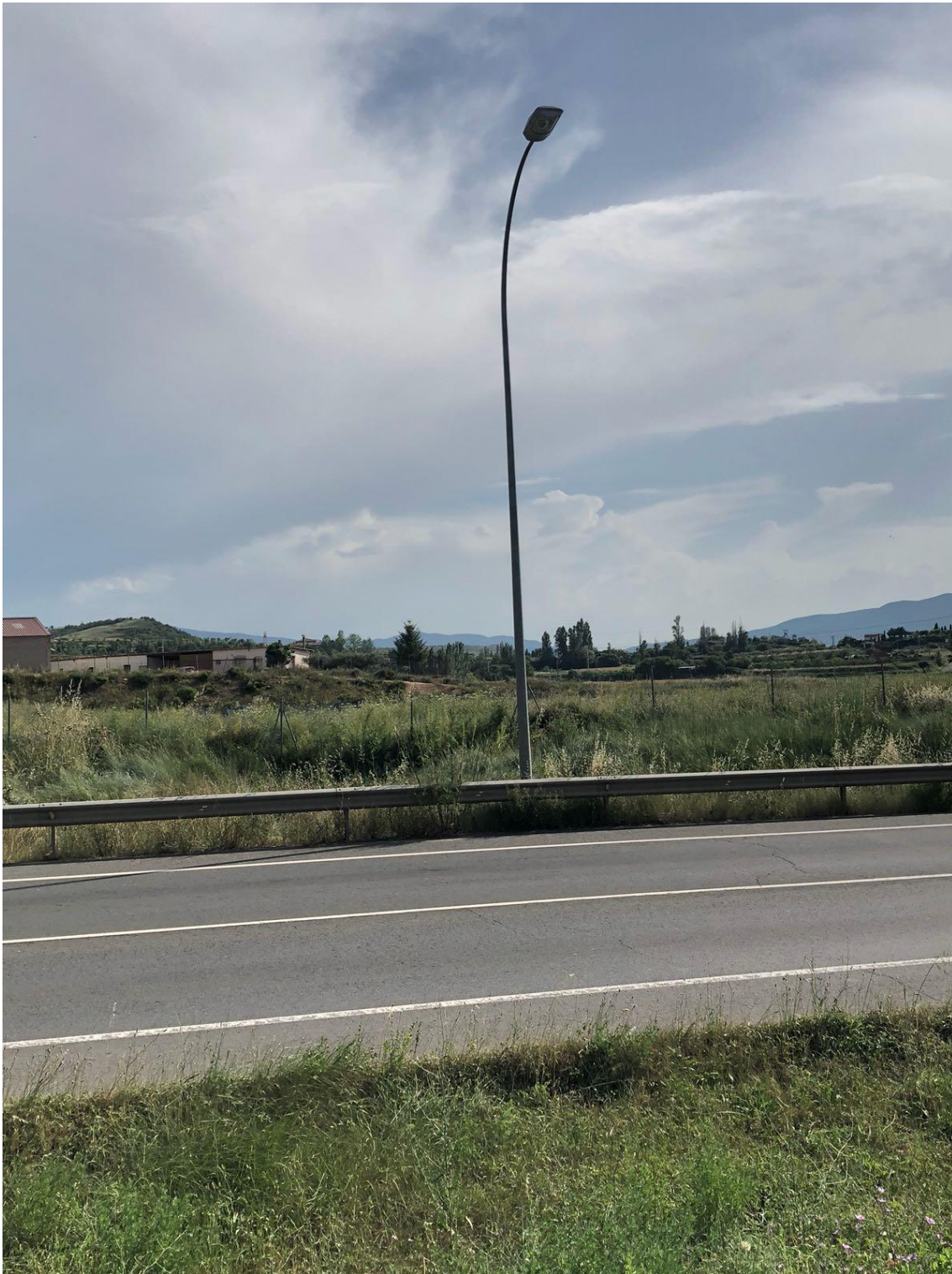
FIGURA 1.6: Luminaria a demoler para la construcción de la obra de paso.
