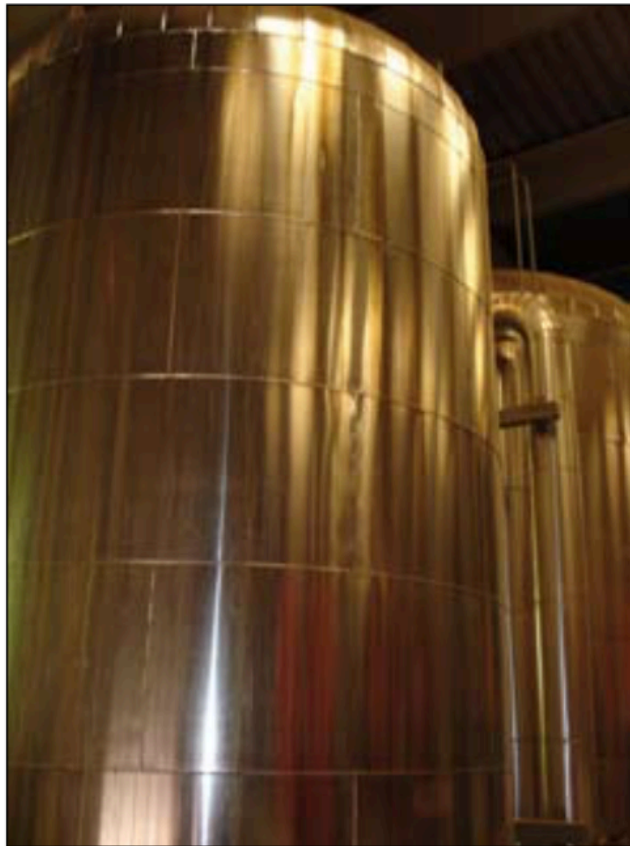
Figura 7, Depósitos de acumulación
