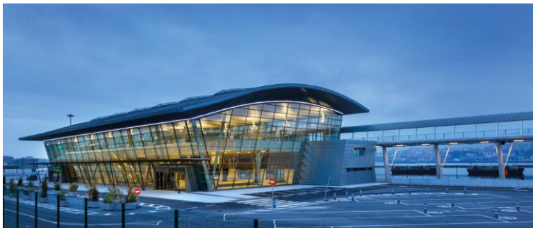
Figura 3 terminal de cruceros
