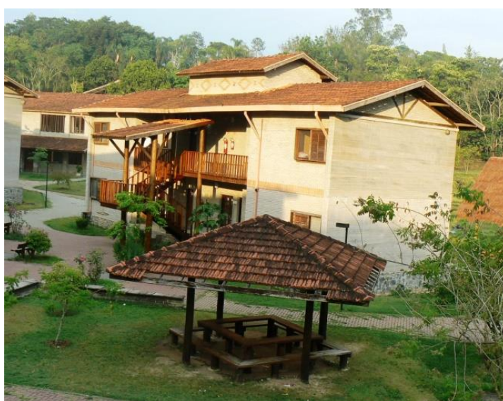
Imagen 3. Edificios de alojamiento y quiosco de estudio ENFF. Fuente: Fotografías propias.
