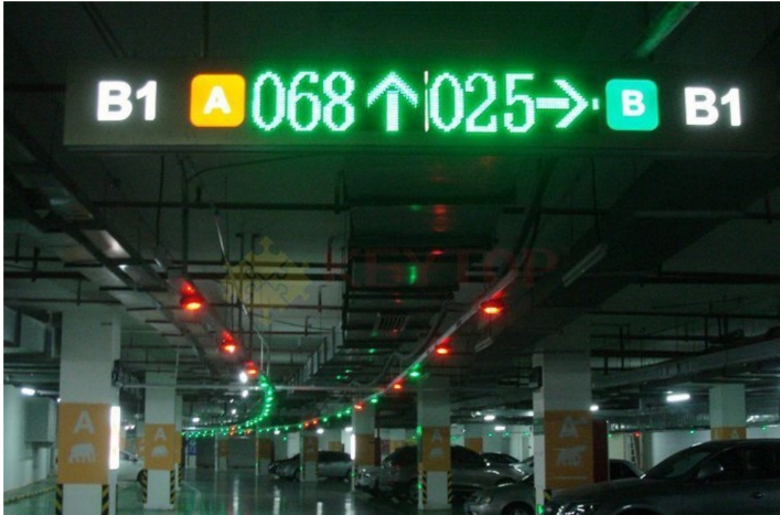
Figura 12.1. Sistema de autoguiado de vehículos. Fuentes: Marca Keytop.
