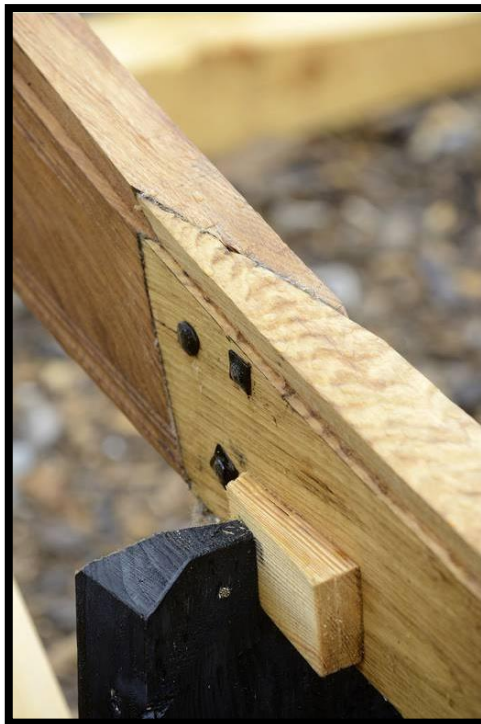
Figura 3.8: Ejemplo de unión de bisel. Fuente: Museo del barco vikingo en Roskilde.
