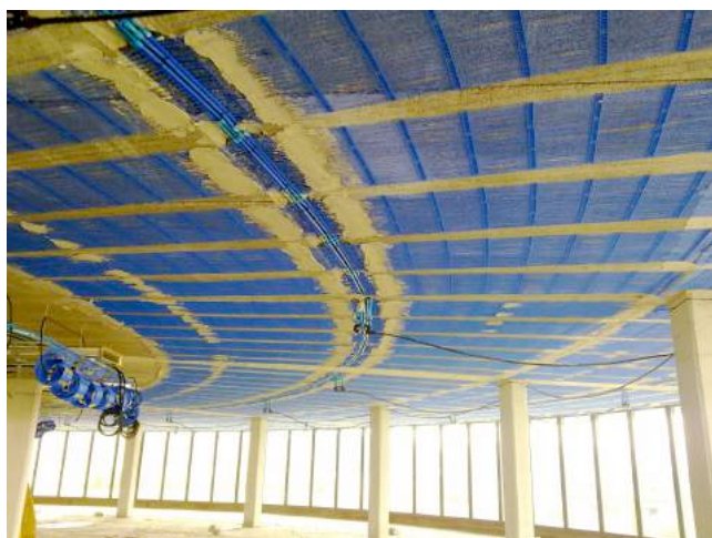
Fig. 33. Fase de montaje de tramas capilares en Edificio Gamesa.
