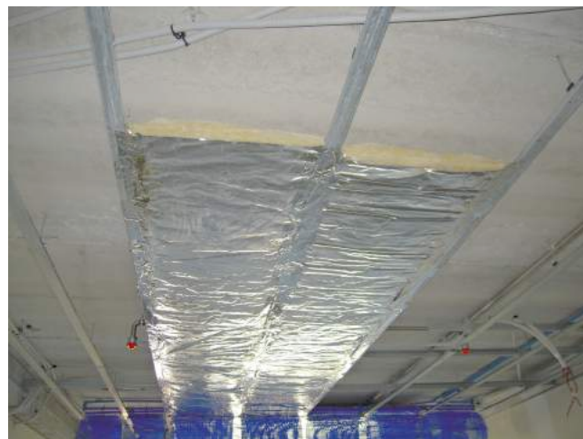
Fig. 46. Fase de montaje en Hotel Muga de Beloso.
