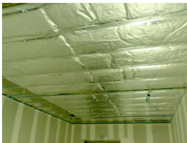
Fig. 40. Fase de montaje de aislamiento en Conservatorio de Navarra.
