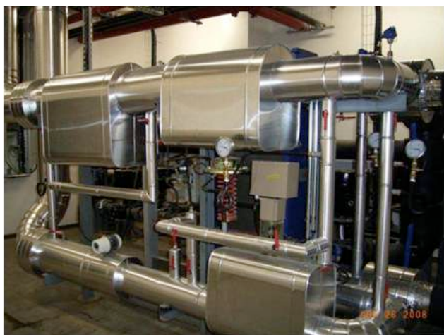
Fig. 6. Subestación de un sistema de calefacción de distrito (districlima mayo 2009).
