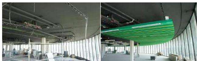
Fig. 35. Fase de enlucido del techo en Edificio Gamesa.
