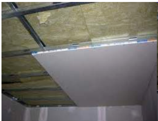
Fig. 23. Aislamiento a cara interna (SATI).
