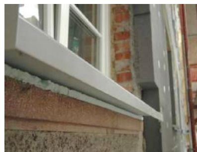
Fig. 21. Aislamiento a cara externa (SATE).
