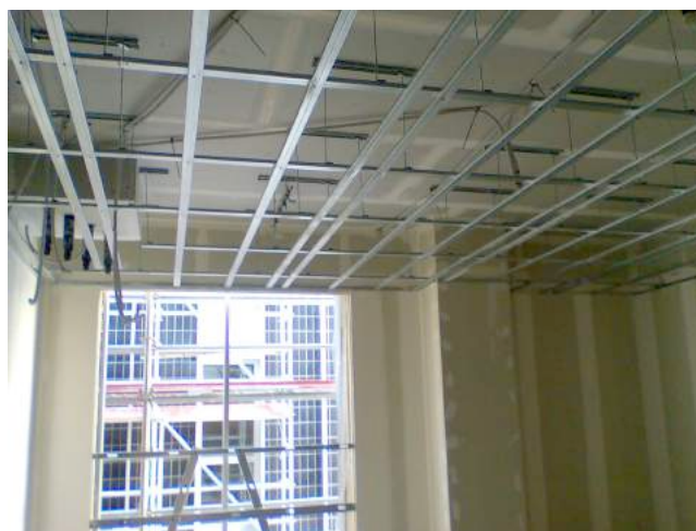
Fig. 39. Fase de montaje de perfilera para placa de yeso seca en Conservatorio de Navarra.
