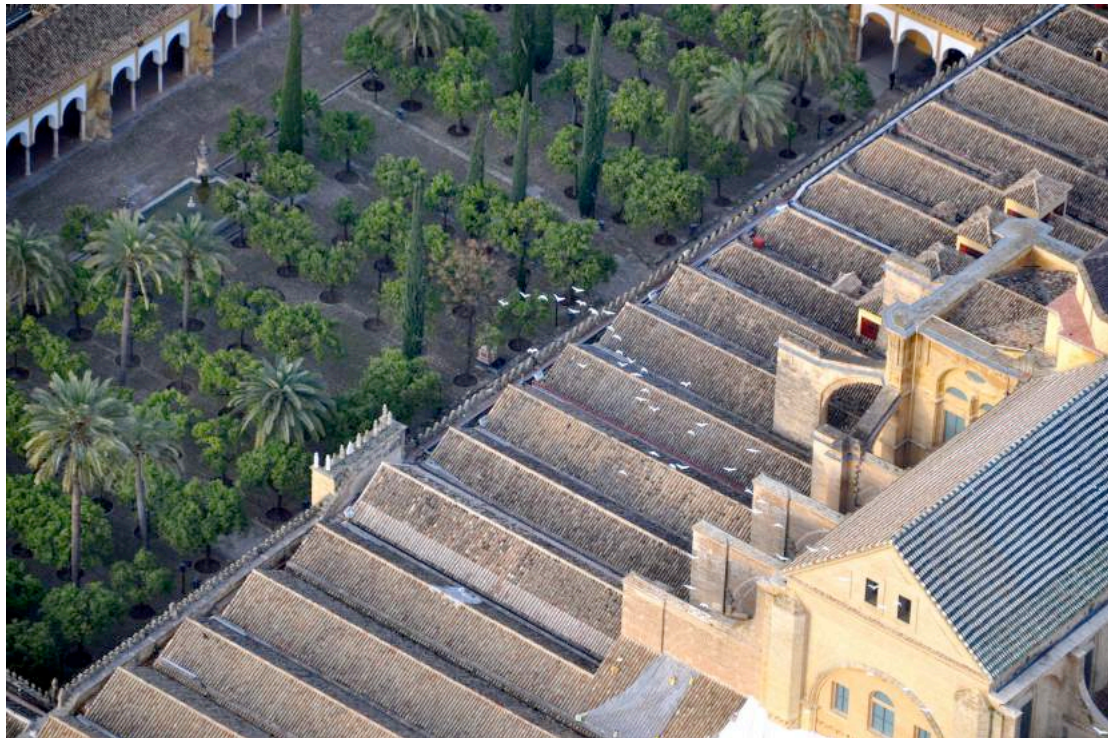
Fig. 5. Vista aérea de la cubierta dentada de la mezquita y su proyección continua sobre la ordenación alineada del patio de los naranjos, en el que la nota orgánica aleatoria la ponen los cipreses y palmeras dispuestos “desordenadamente” sobre la trama geométrica claramente reconocible. Los caminos del agua, trazados desde los canalones entre las cubiertas apuntadas, tienen su continuidad en el plano inferior del patio de los naranjos, y mantienen su continuidad ordenando según su flujo la disposición principal del complejo. Fuente: fichero Wikimedia Commons
