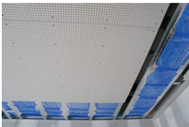
Fig. 42. Fase de montaje de placa de yeso en Conservatorio de Navarra.
