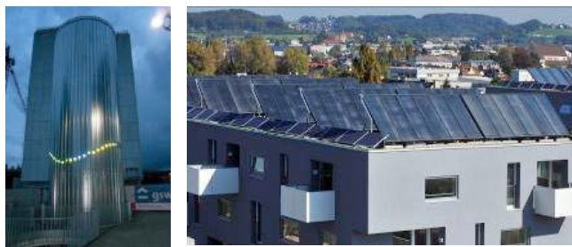
Fig. 33. Tanque de almacenamiento e instalación de campo solar en cubiertas.
