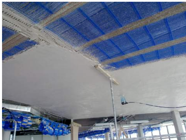
Fig. 34. Fase de enlucido del techo en Edificio Gamesa.
