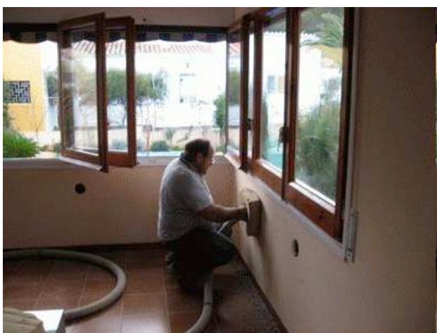
Fig. 27. Aislamiento en cámara intermedia. Puesta en obra.
