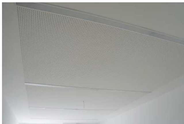
Fig. 37. Detalle del techo con acabado de placa de yeso seca perforada en Conservatorio de Navarra.
