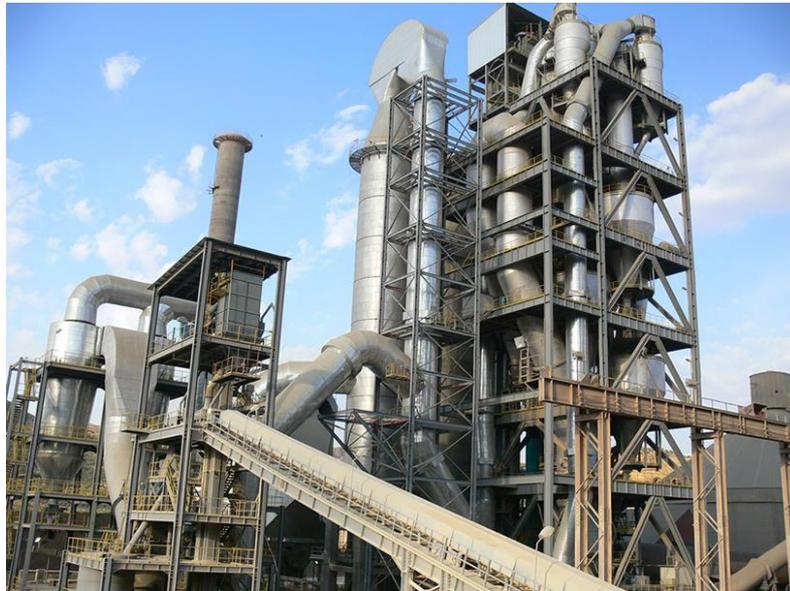
**Ilustración 8.** Torre precalentadores de ciclones
