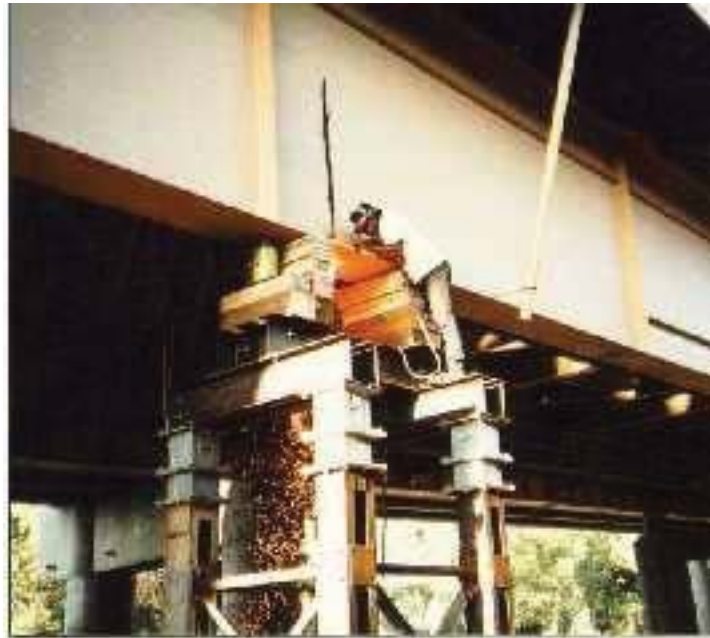
Figura 2.5.4. Puente I-40 sometido a ensayo: grieta provocada sobre el puente.
