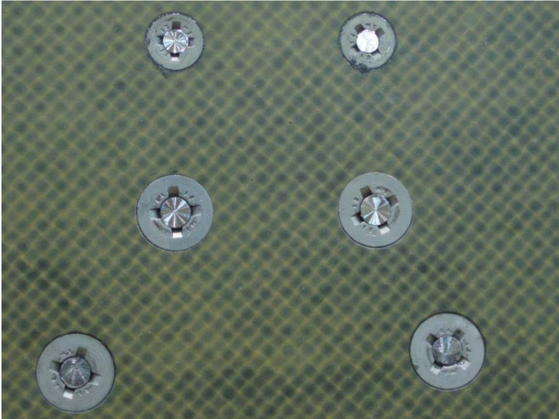
Figura 1.2.5. Muestra de la cara vista tras la instalación de remaches ciegos.
