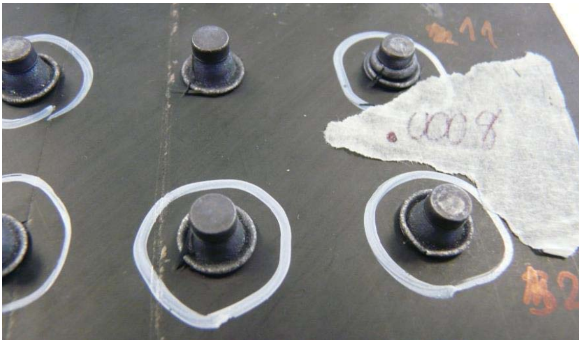
Figura 3.1.3. Detalle de remaches correctamente e incorrectamente instalados (probeta #2, remaches fila superior: 13 – 12 – 11; fila inferior 22 – 21).
