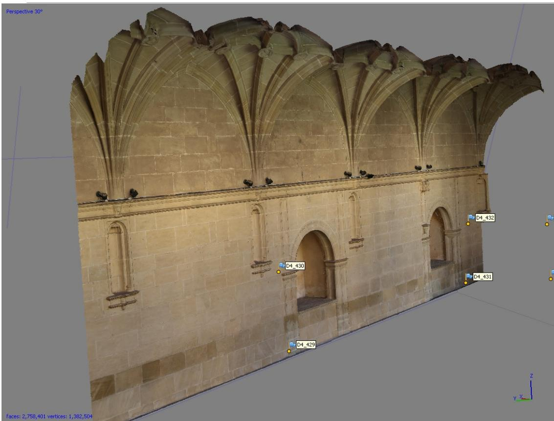
Fig. 25.- Mitad sur del alzado este del interior del claustro (modelo mallado con texturas fotográficas).
