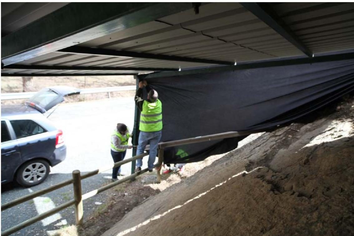
Fig. 7.- Colocación de un toldo para evitar la luz directa y las sombras proyectadas en el área a documentar.
