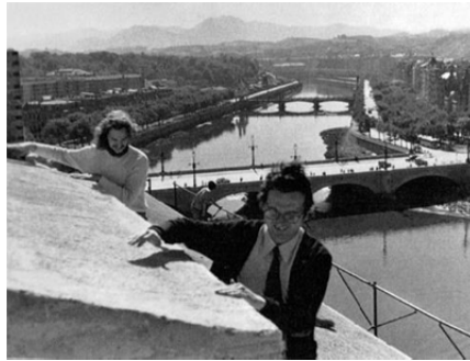
Rafael Moneo durante la visita de obra a la construcción del edificio Urumea, 1971.
