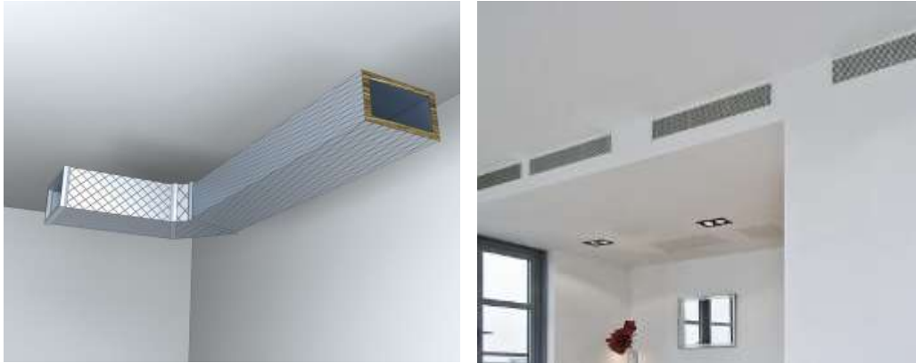
Ilustración 32. Instalación de las tuberías de distribución de aire
