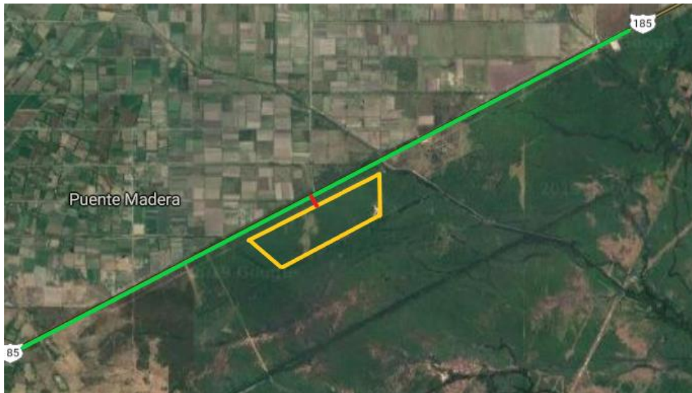
Figura 26. Acceso general al parque eólico.
