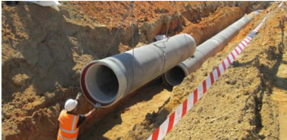
Figura 30. Colocación del tubo de hormigón en la zanja de canalización.
