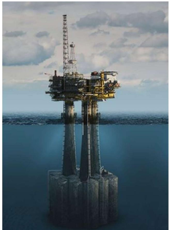
Figura 7-1. Plataforma fija por gravedad
