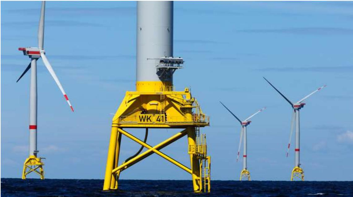
Figura 8-18. Pieza de transición real
