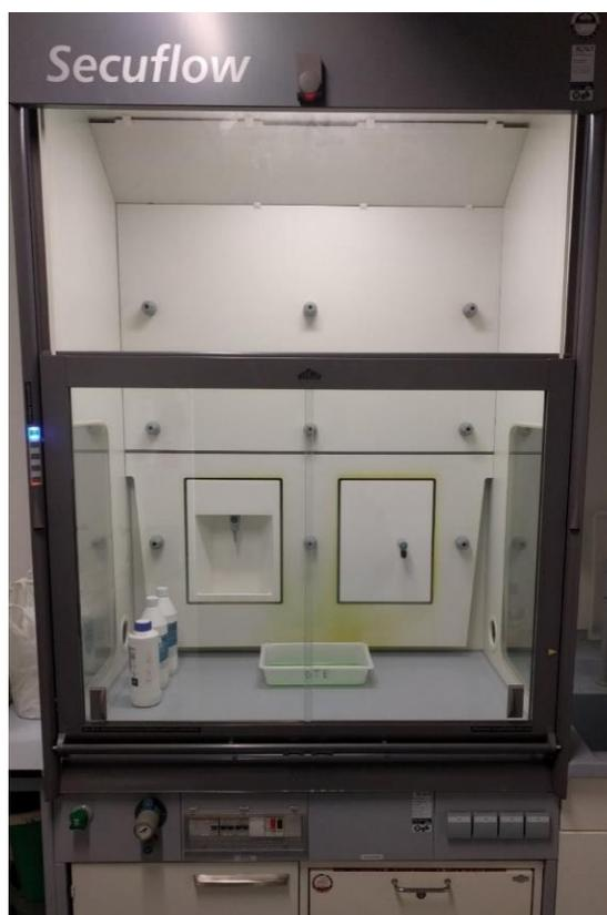
*Figura 61. Campana de extracción de gases*
