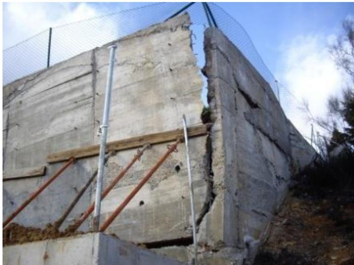
Figura 14. Rotura muro de contención (Fuente: [Enciclopedia Broto](#))
