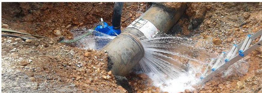
Figura 9. Fuga en tubería enterrada(Fuente: [www.rtarquitectura.com](http://www.rtarquitectura.com))
