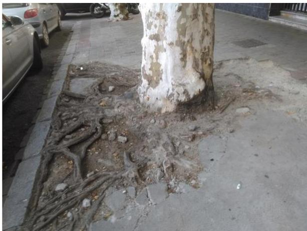
*Figura 27. Daño a pavimento por raíz de árbol(Fuente: [www.patologiasconstruccion.net](http://www.patologiasconstruccion.net))*
