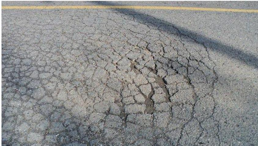
Figura 7. Fisuraciones por fatiga (Fuente: [www.Ingecom.com](http://www.Ingecom.com))
