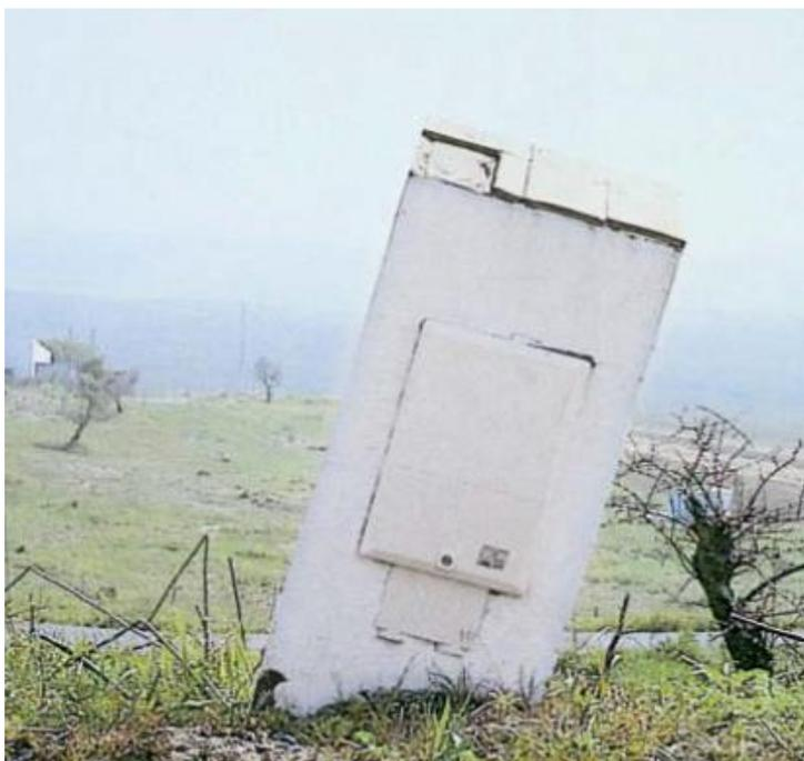
Figura 11. Vuelco de centro de transformación por terreno expansivo (Fuente: [www.structuralia.com](http://www.structuralia.com))
