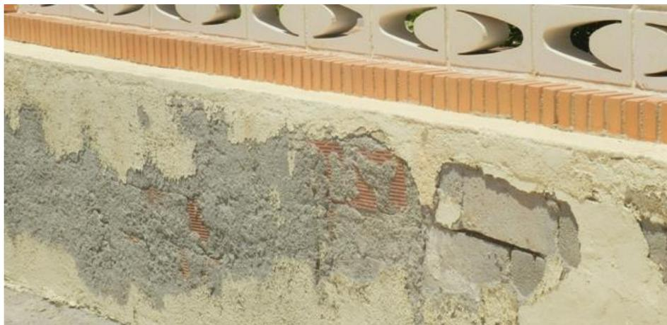
Figura 21. Lesiones por erosión (Fuente: [www.structuralia.org](http://www.structuralia.org))
