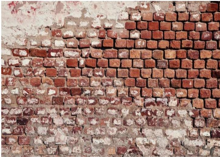
Figura 13. Eflorescencias en muro de albañilería. (Fuente: [www.arquigrafico.com](http://www.arquigrafico.com))
