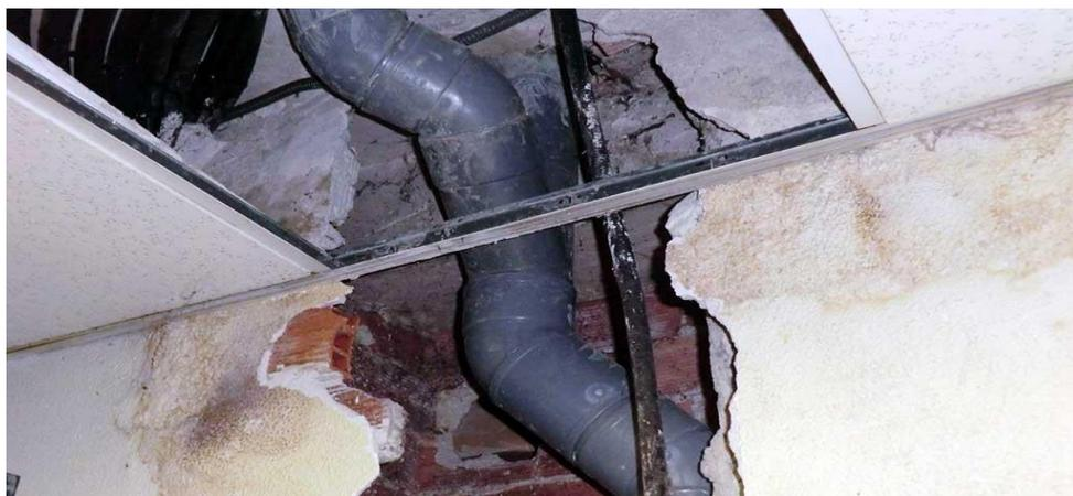
Figura 10. Humedades y daño estructural por fuga (Fuente: [www.rtarquitectura.com](http://www.rtarquitectura.com))
