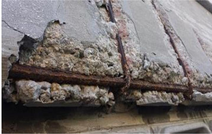
Figura 12. Corrosión de armaduras por filtración (Fuente: [www.humeingeniería.es](http://www.humeingeniería.es))
