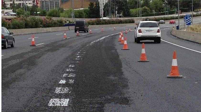
Figura 6. Fallo en mezcla por exceso de temperatura de fabricación (Fuente: [www.structuralia.com](http://www.structuralia.com))
