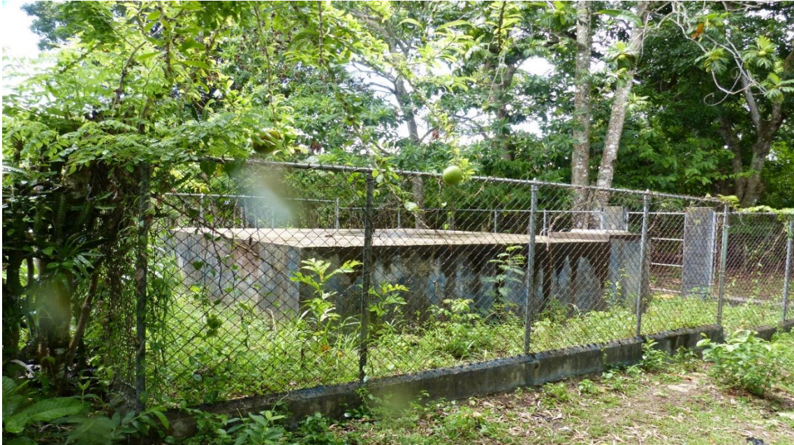
Ilustración 24: Tanque actual con la valla perimetral, Fuente: NUEVI
