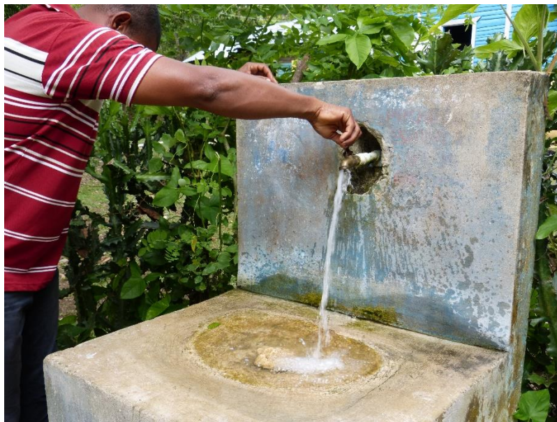
Ilustración 6: Fuente central y grifo de válvula, Fuente: NUEVI
