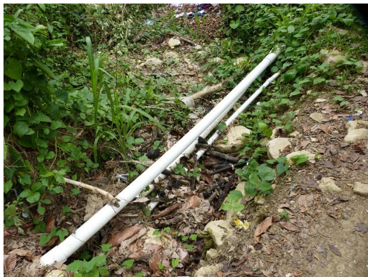
Ilustración 28: Tubería de suministro actual, Fuente: NUEVI
