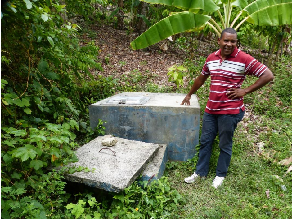
Ilustración 30: Recubrimiento de la caja de válvulas, Fuente: NUEVI
