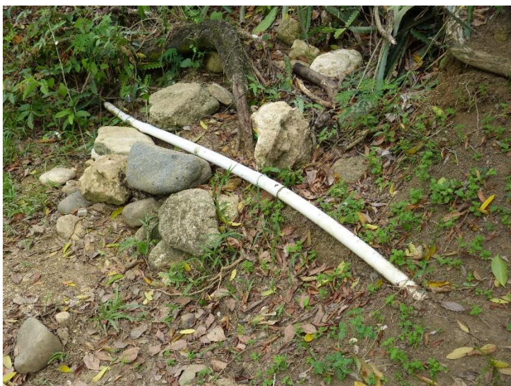
Ilustración 27: Tubería de suministro actual, Fuente: NUEVI
