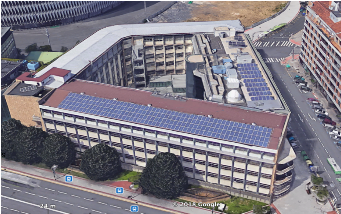
Ilustración 5 - Instalación fotovoltaica del EVE
