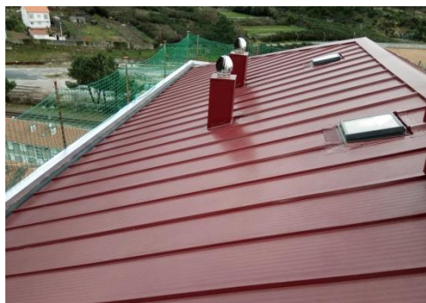
Fig. 15 Ejemplo cubierta de panel Sándwich
