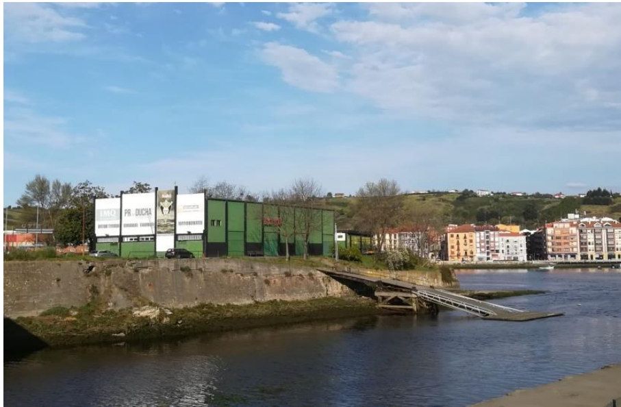
Fig. 4 Paso del río Galindo por el lateral del pabellón y desembocadura de éste en la ría de Bilbao.
