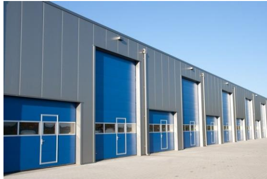
Fig. 12 Ejemplo de Panel Sándwich en Fachada
