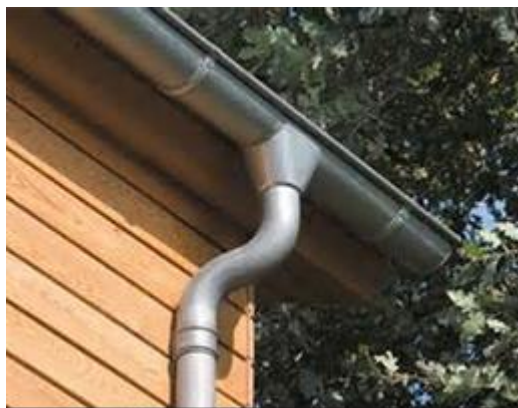
Fig. 3 Ejemplo de canalón y su bajante
