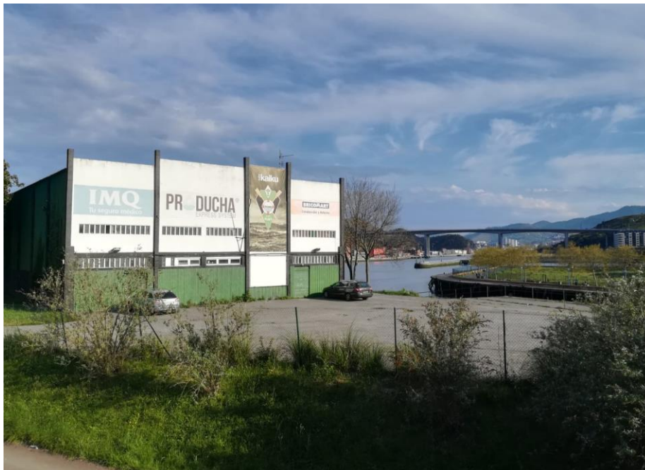
Fig. 3 Vista frontal del pabellón y de la ría de Bilbao a la derecha.
