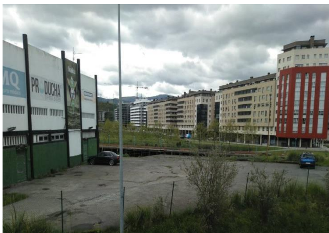
Fig. 2 Situación actual del firme en la zona de aparcamiento
