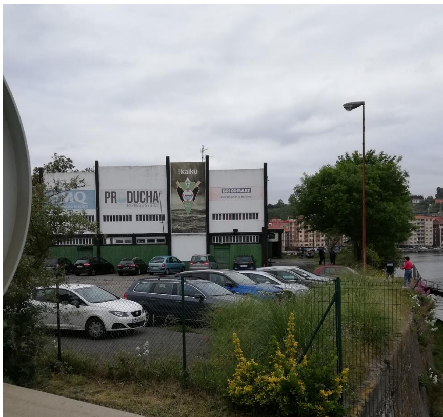
Fig. 9 Uso del aparcamiento actual. Vista 1
