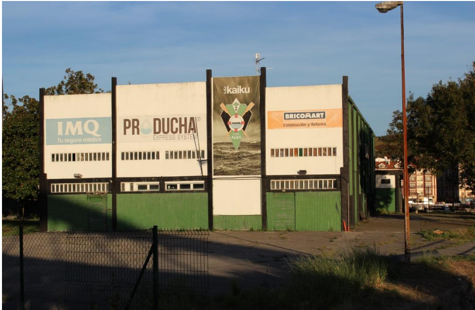
Fig. 2 Vista frontal del pabellón actual y espacio de estacionamiento para usuarios.
