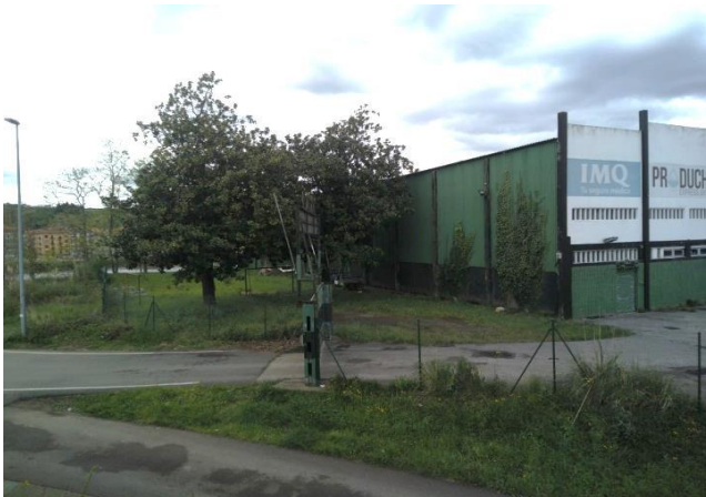
Fig. 1 Situación actual de la entrada al recinto donde se observa los diferentes firmes.
