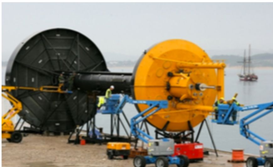
Figura 1.6-12. Prototipo de la PowerBuoy instalada en Santoña (España)
