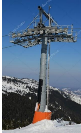
Ilustración 10. Balancín de un pilar de teleférico
