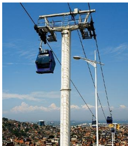
Ilustración 9. Pilar de una instalación de teleférico
