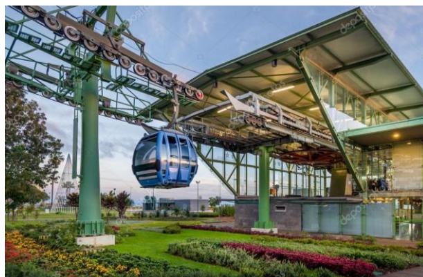
Ilustración 7. Estación de teleférico
