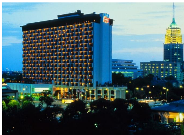
Figure 2.1.5 Actual image of Hotel Palacio del Rio in San Antonio, U.S.A.
