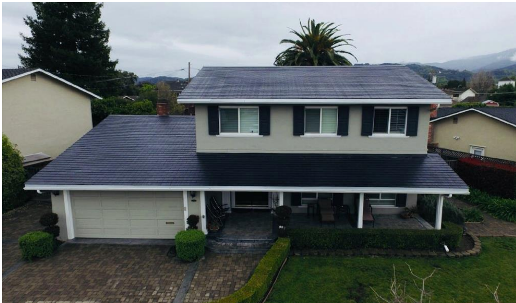
Figura 17. Cubierta con tejas solares Tesla [16]
