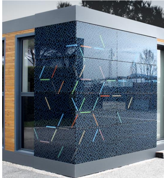
Figura 12. Fachada con vidrios de diseño
