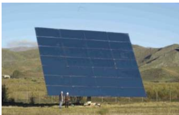
FIGURA 20: HELIOSTATO DE 120 M 2 DISEÑADO POR SOLÚCAR S.A PARA LA PLANTA PS10
