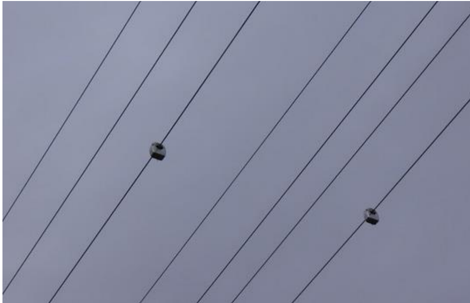
Ilustración 21. Sistemas de monitorización de temperatura.
