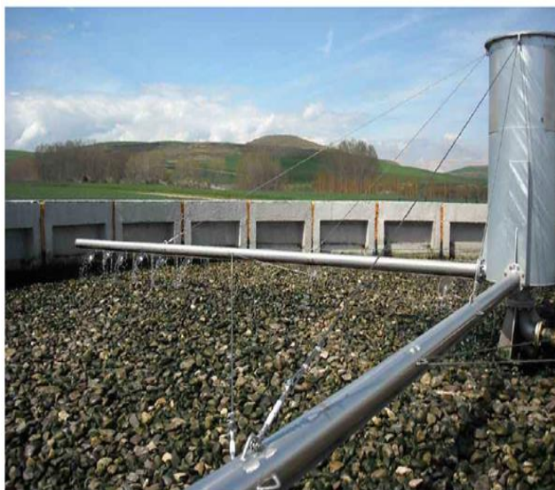
Figura 29: Esquema partes filtro percolador. [53]
