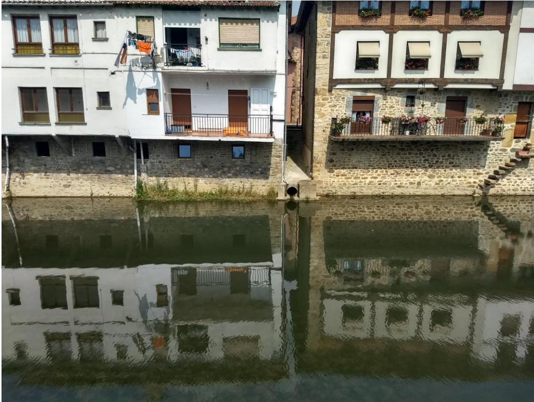
Figura 15: Vertido de las aguas residuales del barrio de Zubiaur.
