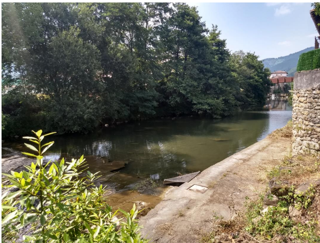
Figura 3: Punto de conexión entre la EDAR y la red de saneamiento. (Propia)
