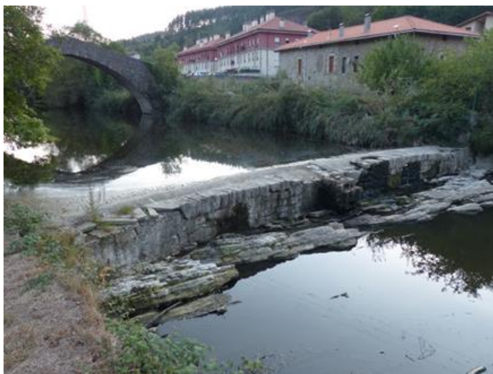
Figura 7: Estancamiento del río a su paso por Luiando por su falta de caudal.
