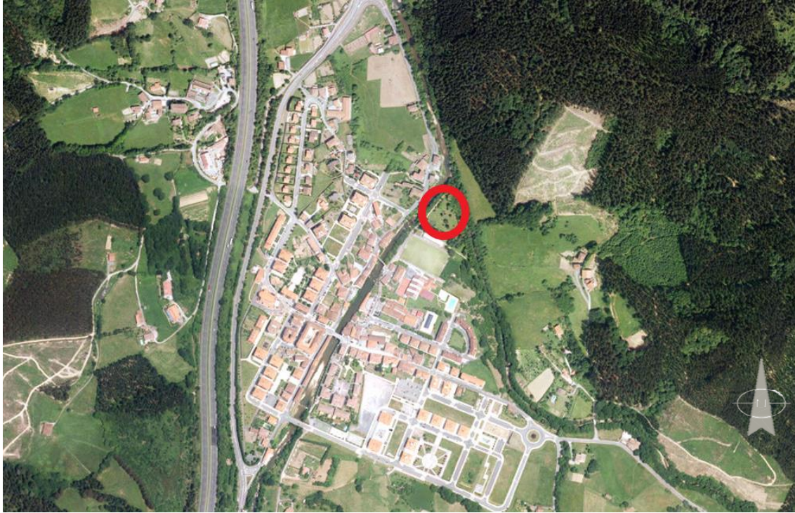
Figura 10: Situación final de la EDAR. (Propia mediante Geoenskadi)
