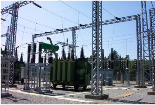
ILUSTRACIÓN 5, SUBESTACIÓN AIS
