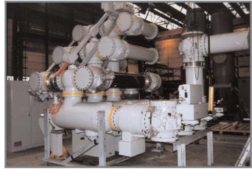
ILUSTRACIÓN 6, SUBESTACIÓN GIS
