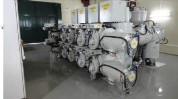
ILUSTRACIÓN 14, SUBESTACIÓN GIS
