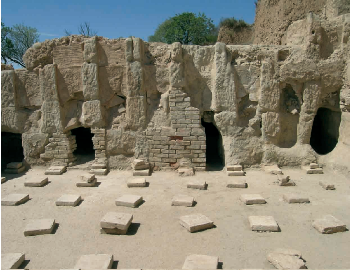
FIGURA 12. Hypocaustum del caldarium de las Termas I. Se pueden apreciar los conductos del aire caliente tallados en los sillares de arenisca. (Foto equipo Labitolosa)
