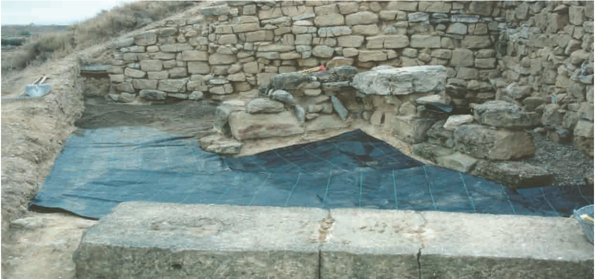
FIGURA 1. Anastylosis de los muros y colocación de mallas geotextiles sobre el pavimento original antes de la deposición de las capas de arena y grava.
