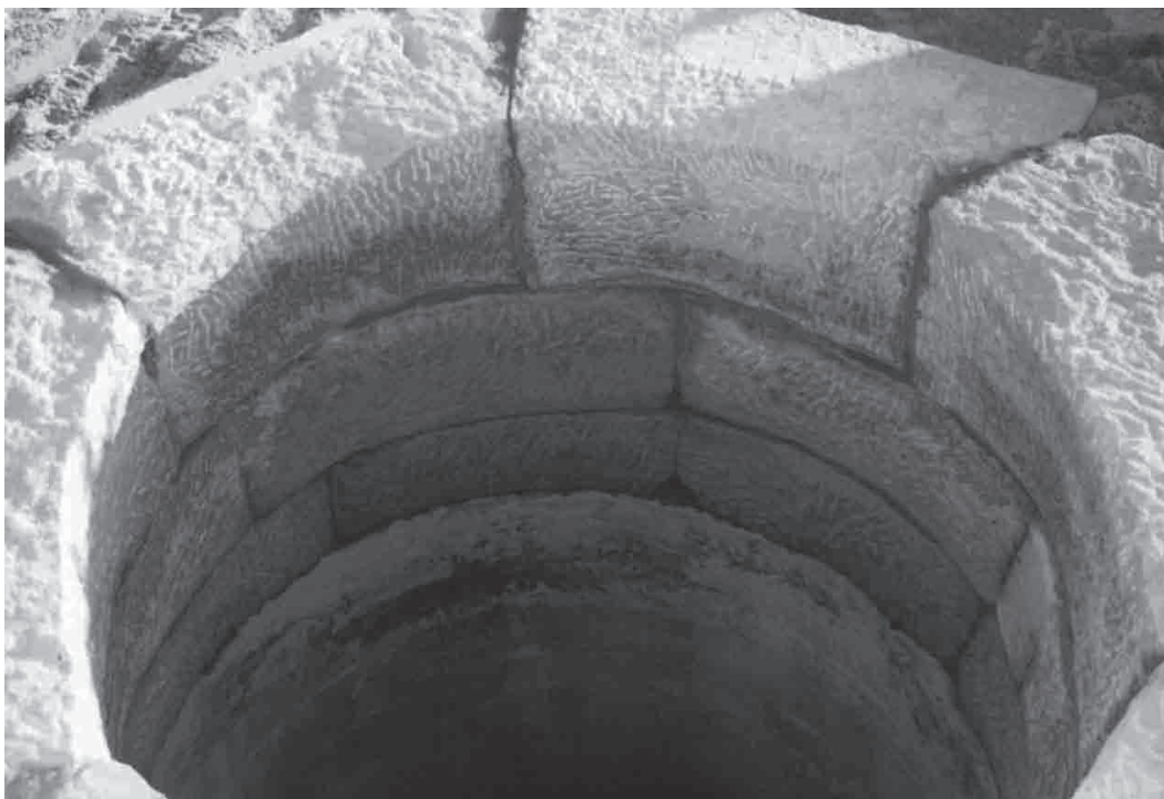
FIGURA 7. Interior de la cisterna tras la consolidación.
