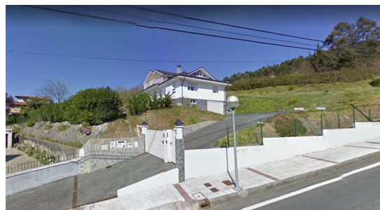
Ilustración 5. Vista de la vivienda afectada
