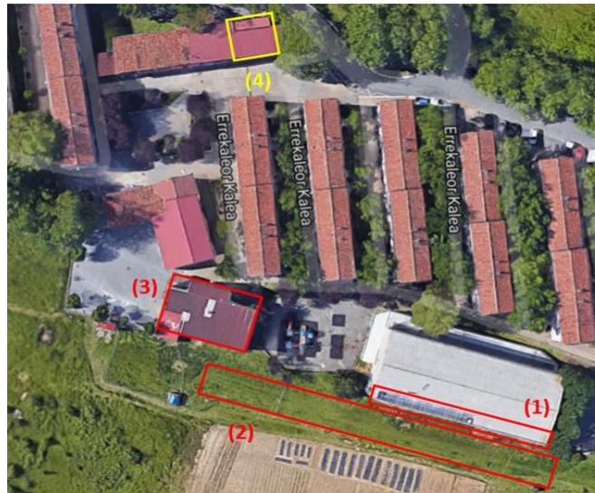
36.Irudia: Plaka fotovoltaikoen instalakuntza gunek[4]
