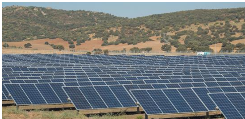
19.Irudia: Plaka fotovoltaikoen instalakuntza
