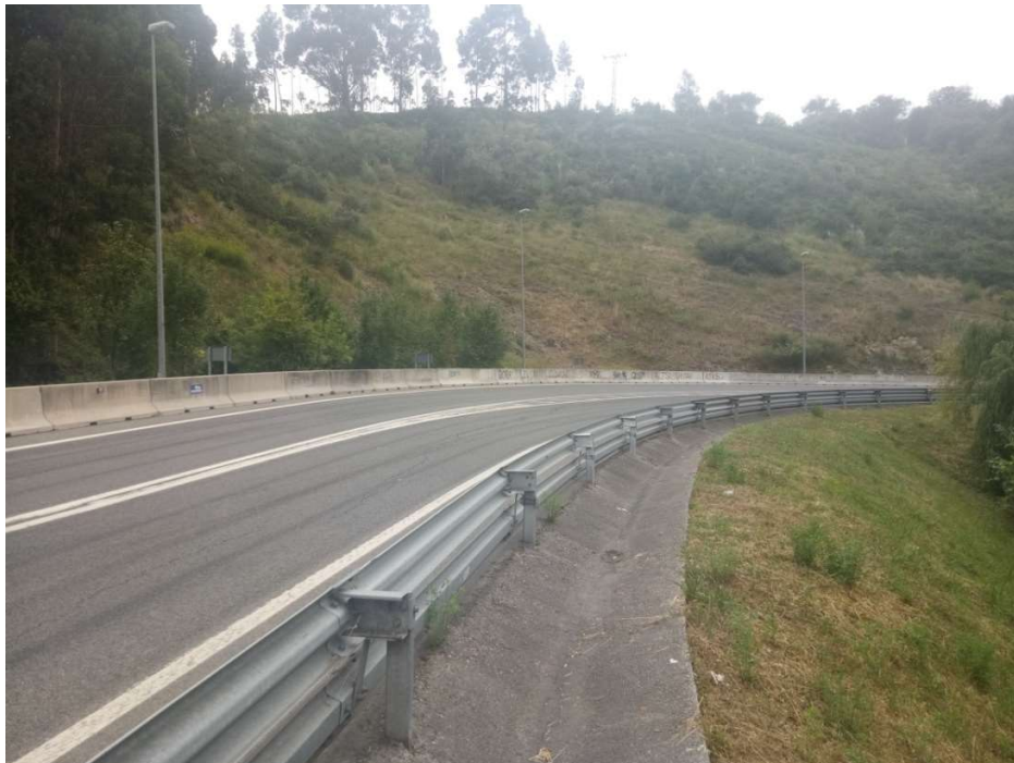
Imagen 1.2.3. Carretera existente glorieta 1.
