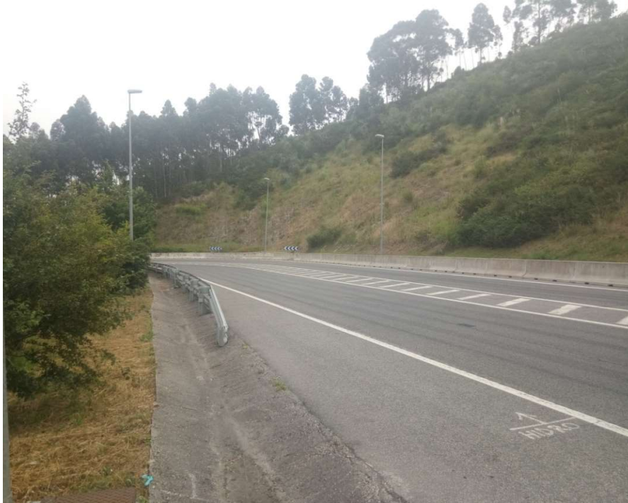
Imagen 1.2.2. Carretera existente glorieta 1.
