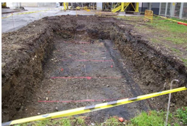
Figura 2. Balizado de zonas de excavación
