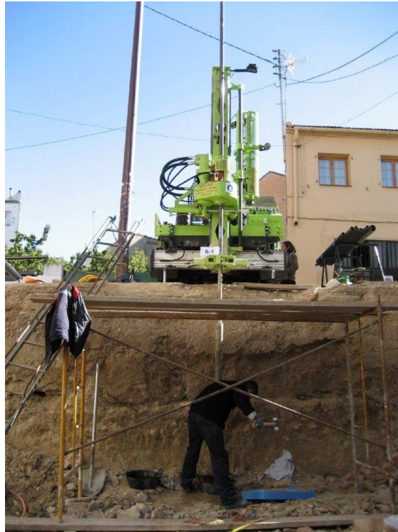
IMAGEN 1. "SONDEO MECÁNICO A ROTACIÓN"
